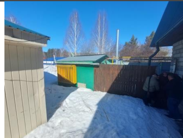
Основная котельная с ограждением
