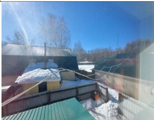
Вид на здание Склад-мастерская и внутреннее ограждение
