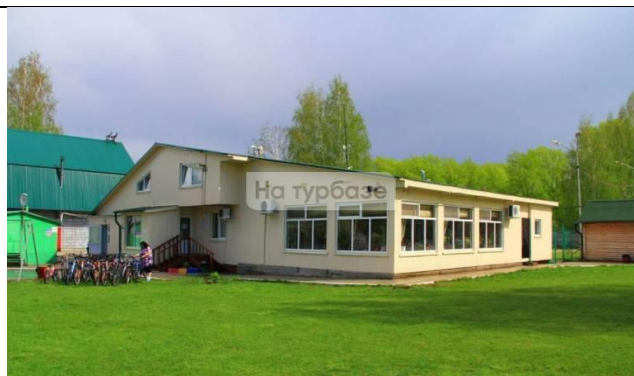
На фото по центру основное строение лыжной базы. В левой части видно здание котельной и двухэтажное кирпичное здание бани-прачечной. В правой части фото видно часть теплой беседки.
